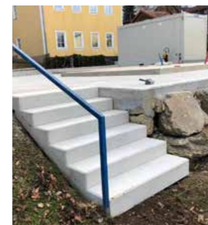
Lieferung des Sanitärcontainers und Versetzen der Stiegen (oben), Holzbau und Terrasse (unten)
